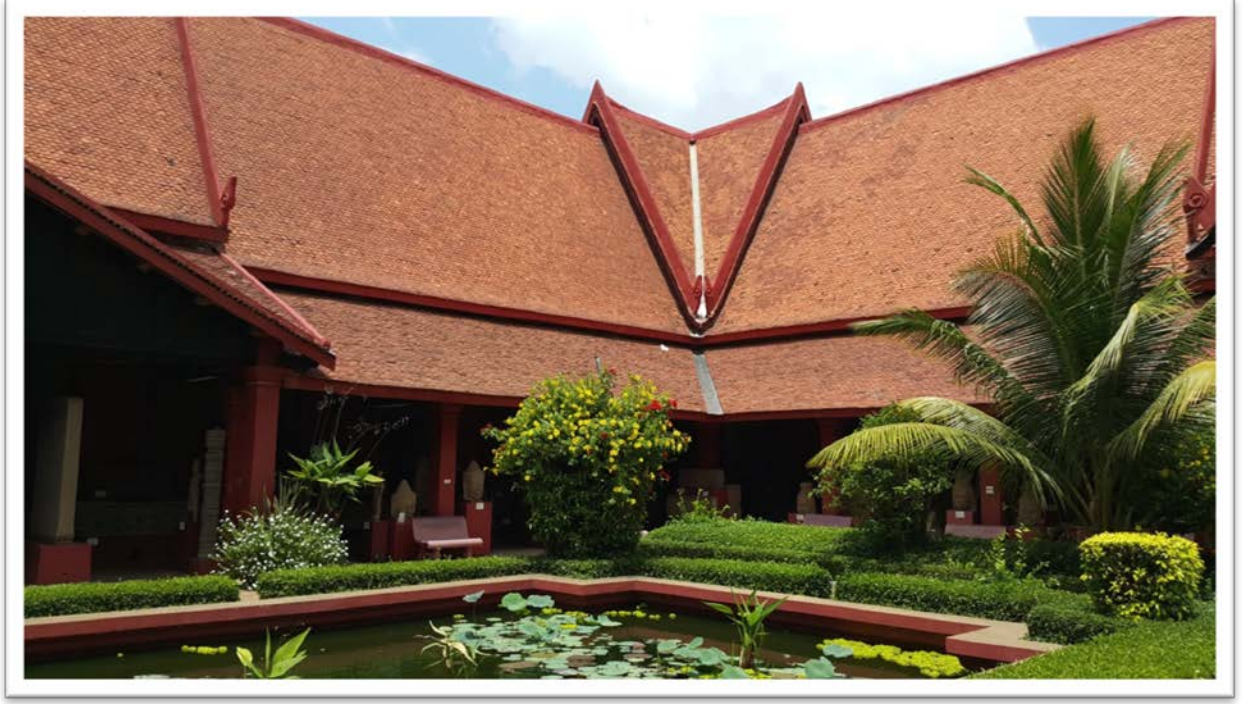
Görsel 32: Müze binâsı ve havuzlu bahçesinden bir görünüm. (Fotoğraf: İ.S.)
